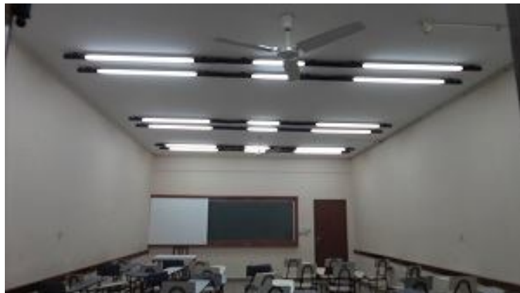
Figura 1: Sala de aulas de la FPUNE.
